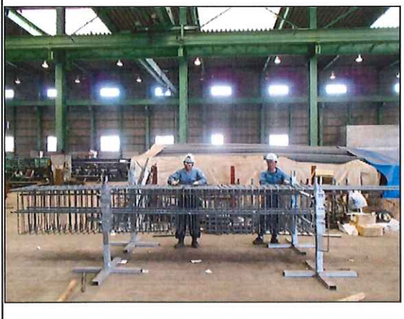
ジャバラ工法（工場にて先組）
