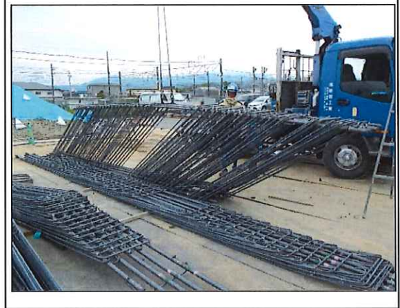
ジャバラ工法（復元して建込）
